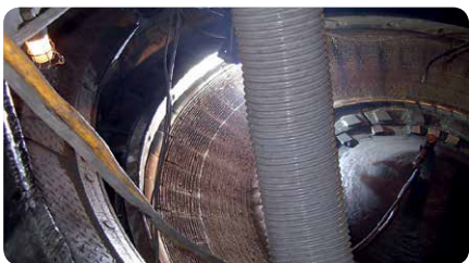
Obnova brúsnych tanierov na mieste (vertikálne mlyny)
